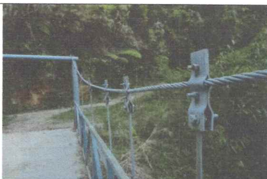
7. Abrazadera metálica superior, barras circulares y cable
