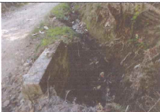
0. Extremo del tubo introducido bajo la vía
