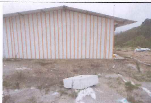
16. Lavadero sin instalar
