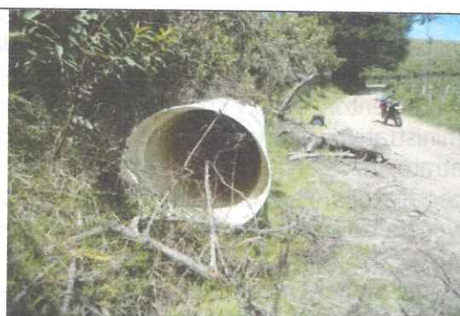
8. Tubos plásticos doble pared corrugados
