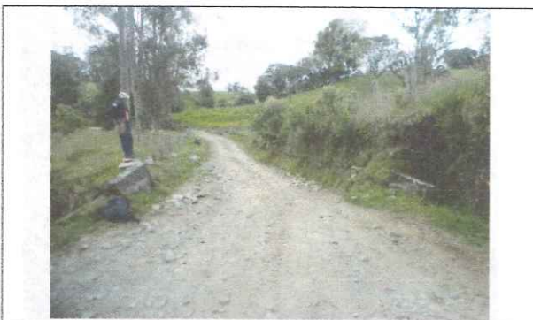
16. Zona de instalación del tubo
