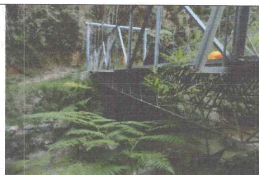
6. Elementos contratados y adicionales
