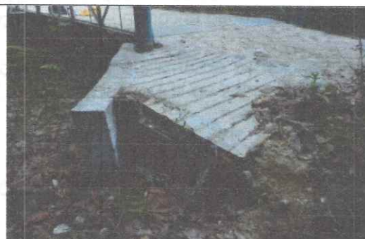
4. Rampa de aproximación
