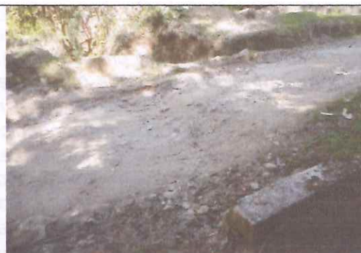
1. Asentamiento en vía por instalación inadecuada del tubo
