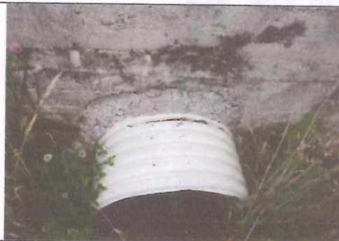
15. Tubo plástico instalado
