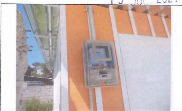
97. Medidor Eléctrico
