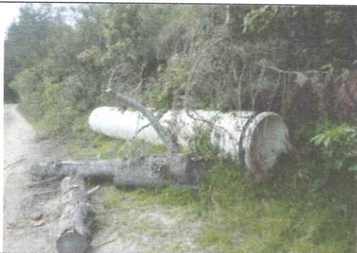
7. Tubos de 6,5 m y de 36"
