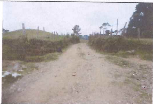
3. Zona de instalación bajo vía veredal
