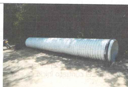
9. Tubos PVC depositados a orilla de carretera
