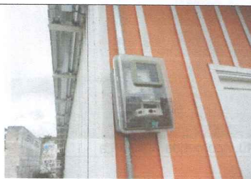
47. Medidor eléctrico
